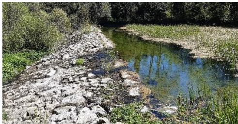
Etat de la paissière avant nettoyage ↑
