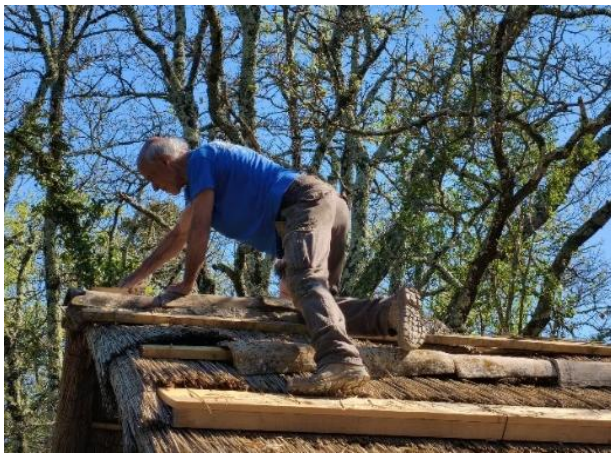
Pose du béton et des tuiles, fini pour ce jour, il faudra revenir pour finir la pose des tuiles.
