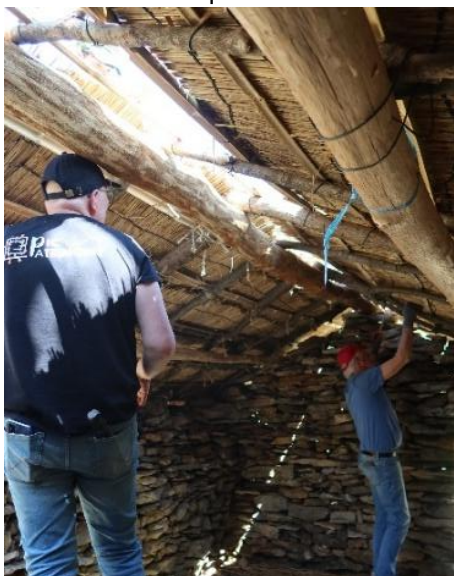
Pendant que certains accrochent les paillons, d'autres découpent la paille pour le béton à la chaux
