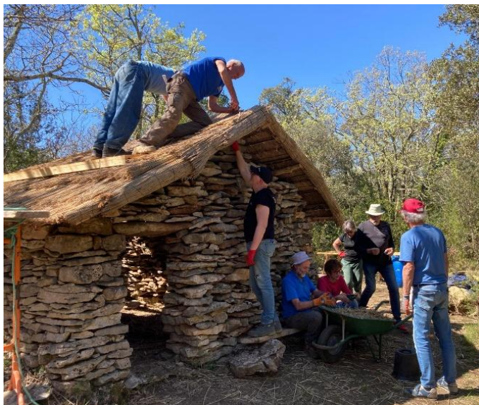
Pendant que certains accrochent les paillons, d'autres découpent la paille pour le béton à la chaux
