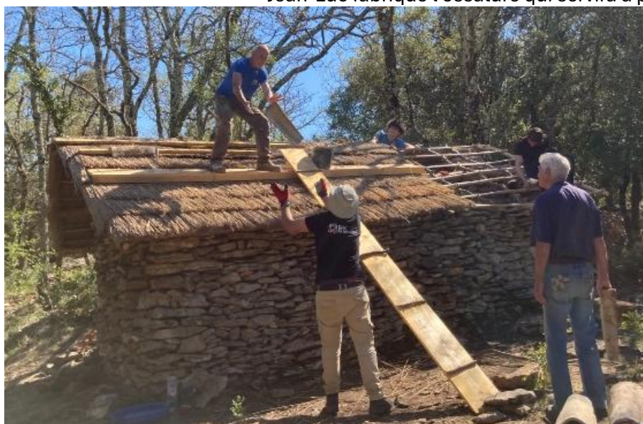
Jean-Luc fabrique l'ossature qui servira à poser les tuiles.
