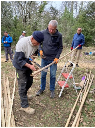
Couper les bambous. Calculer la distance entre les liteaux et la noter sur chaque chevron. Couper le bas et ...
