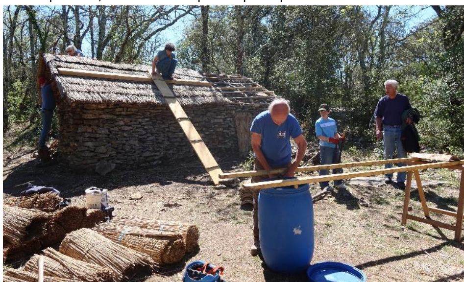
Jean-Luc fabrique l'ossature qui servira à poser les tuiles.
